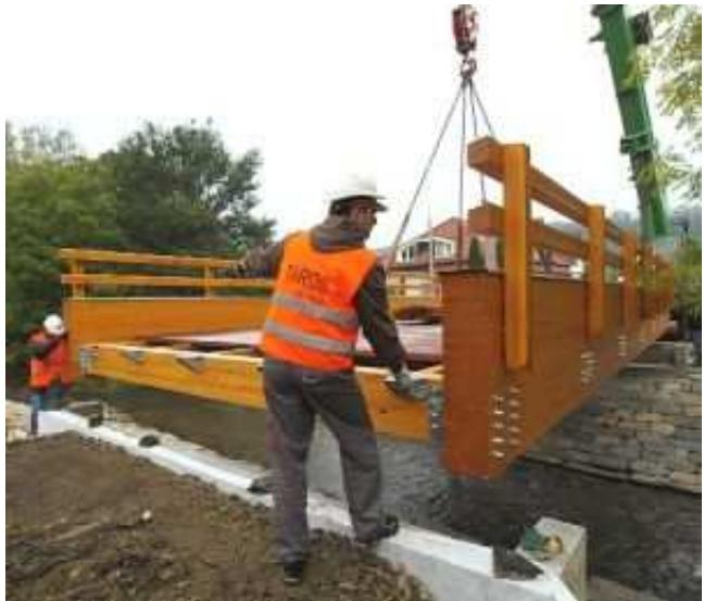
(/images/stories/articles/709/lavka09x.jpg)Nová lávka od firmy Taros z pražské Ruzyně, která se však kompletovala na Kladně, má půdorys 5 x 12,8 metru. Jejími hlavními nosnými prvky jsou lepené dřevěné vazníky.
